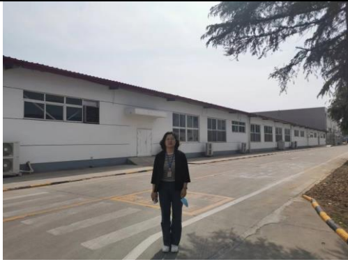
现有车间厂房
